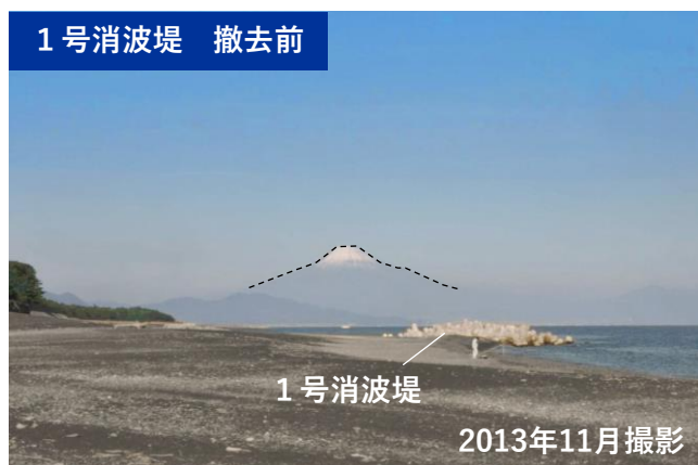
1号消波堤ブロックが小高い丘を形成し景観を阻害
